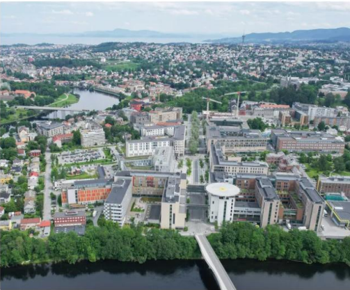
Forskningsprosjektet Flexreg skal finne ut hvordan elkjeller, varmepumper, nødaggregater og batterier kan aktiveres for å balansere kraftsystemet. Store bygningseiere, som St. Olavs hospital i Trondheim, er med i prosjektet. (Foto: St. Olavs hospital)
